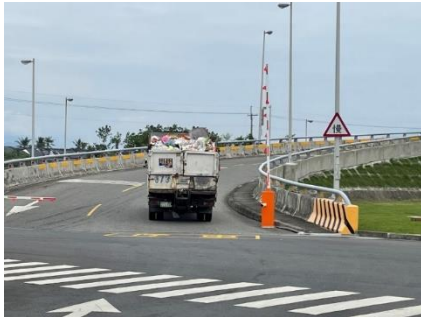
▲圖 4-3、傾卸平台坡道前新增車牌辨識系統
