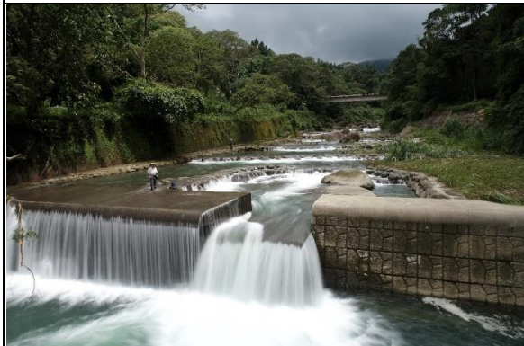
南投分署和雅橋上下游固床工改善三期工程
