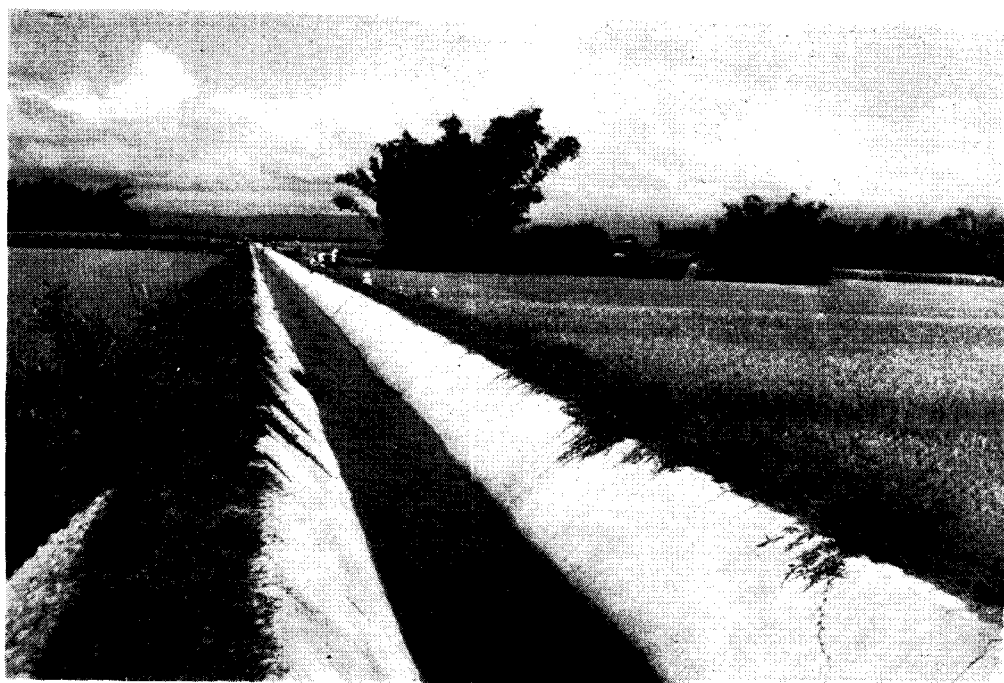
已中年十去過。工面內土凝混用採渠溉灌干若省本 。上以哩○○。工面內道渠種此有建
