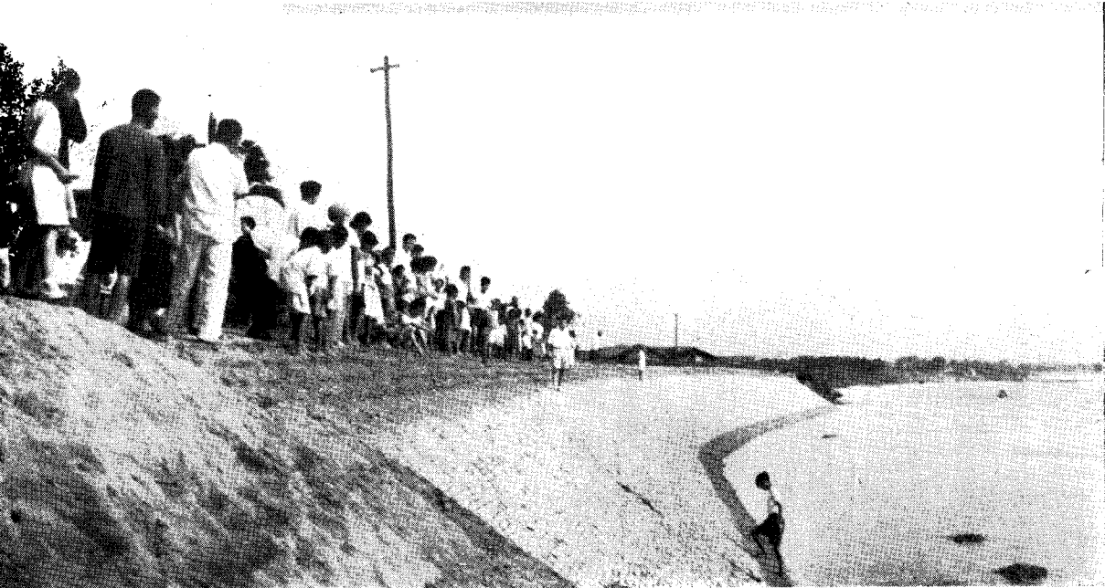
。堤上護保岸護砌磚用旁兩流河積沖
