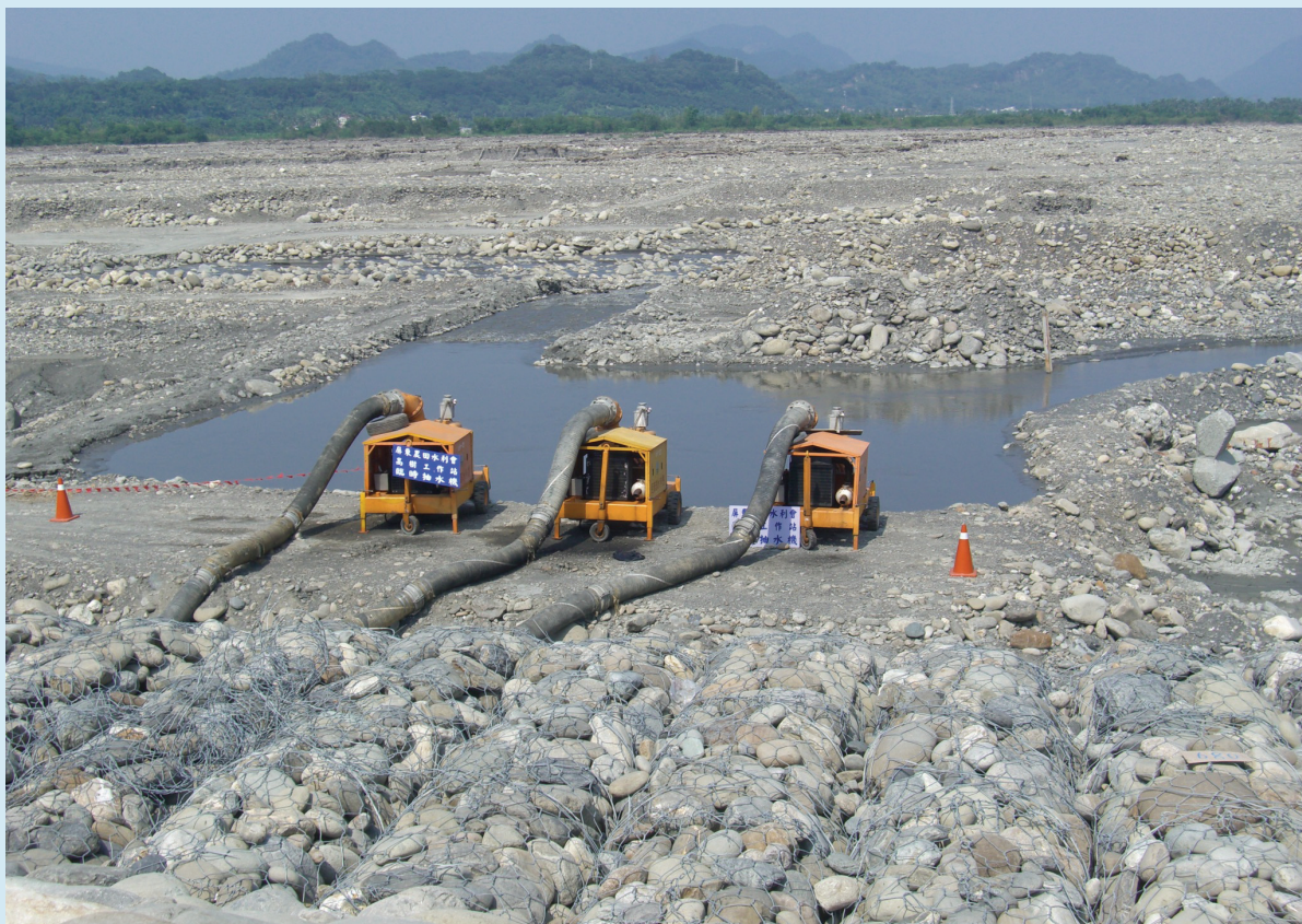
抽水機放置及抽水管線施設情形。
