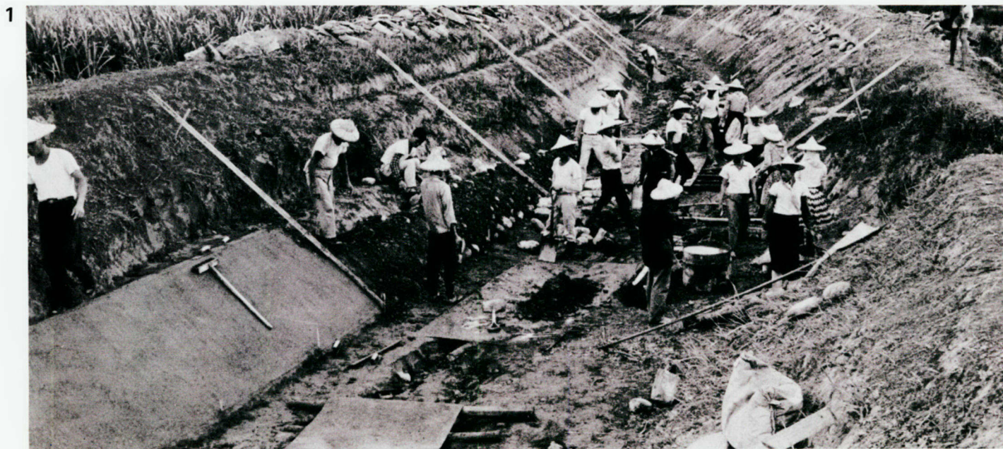
1. 土渠水路鋪設內面工情形。 Concrete-lining of an earth canal.
