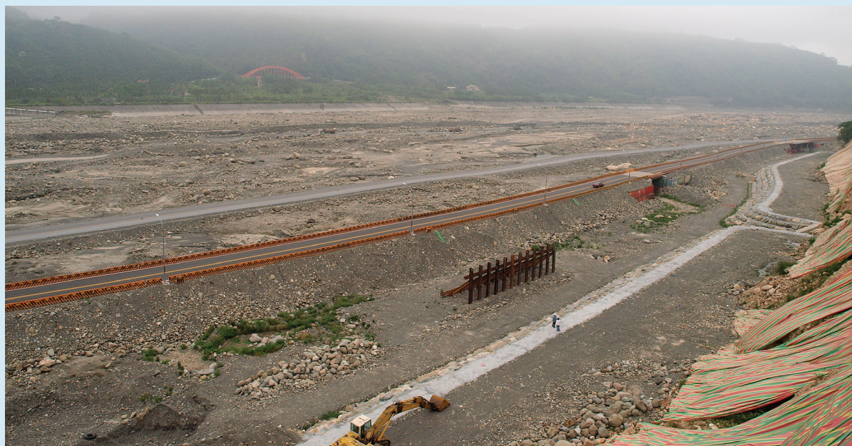
台21線流失八百公尺，臨時道路用貨櫃做模板，盡速搶通。
