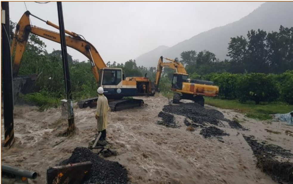
台27-13K-慧濟寺與山水災園區路牌前搶通
