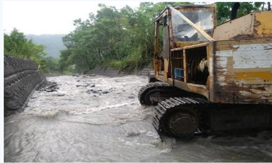
重機械清除藤枝林道舊潭2號野溪土砂
