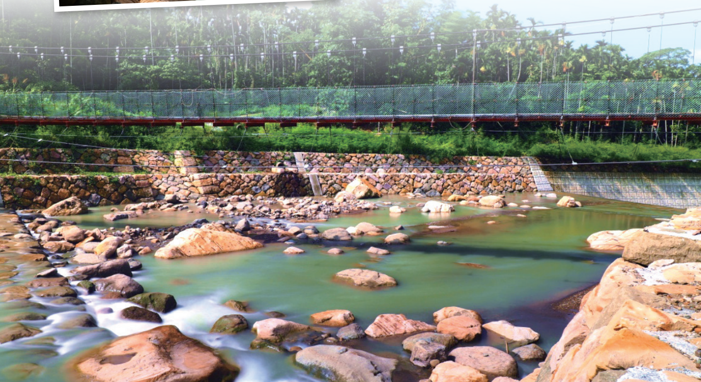
南投縣中寮鄉—粗坑吊橋上游野溪整治二期工程。
