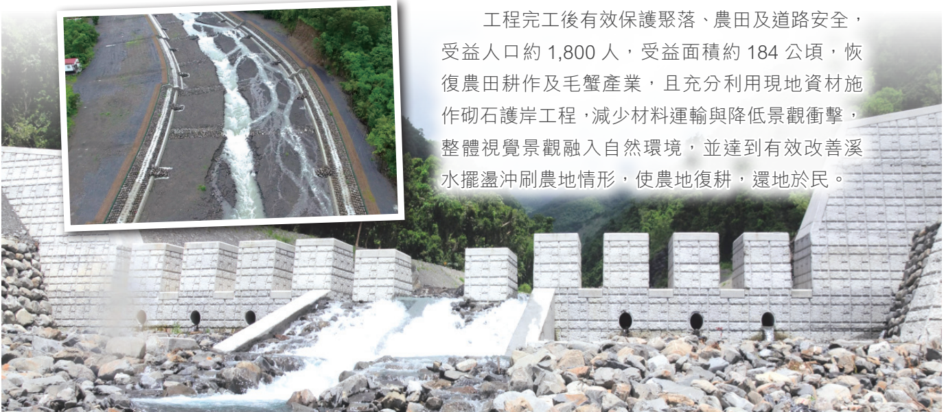
臺東縣達仁鄉—台坂溪野溪治理二期工程。
