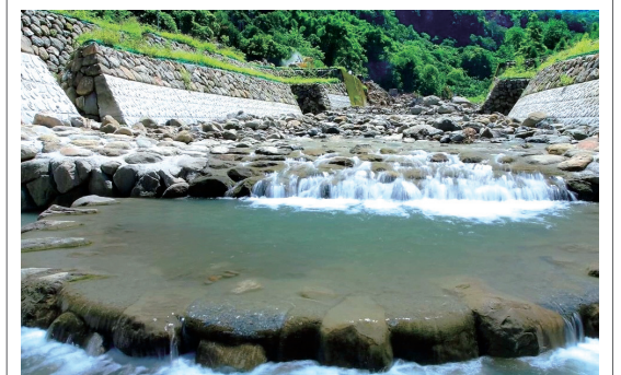
臺中市太平區—頭汴坑溪中埔十號橋上游整治工程。
