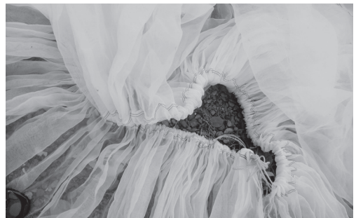
利用金屬環連接繩與網，防風網可順利度過中度颱風的危害。
