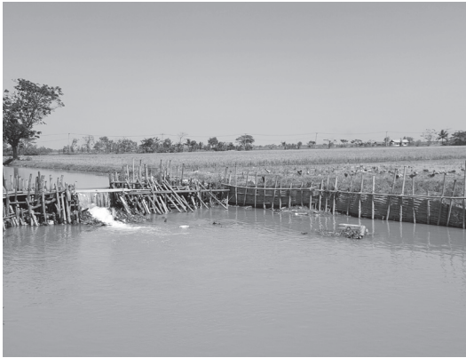
當地傳統以竹柵製成攔水閘門。
