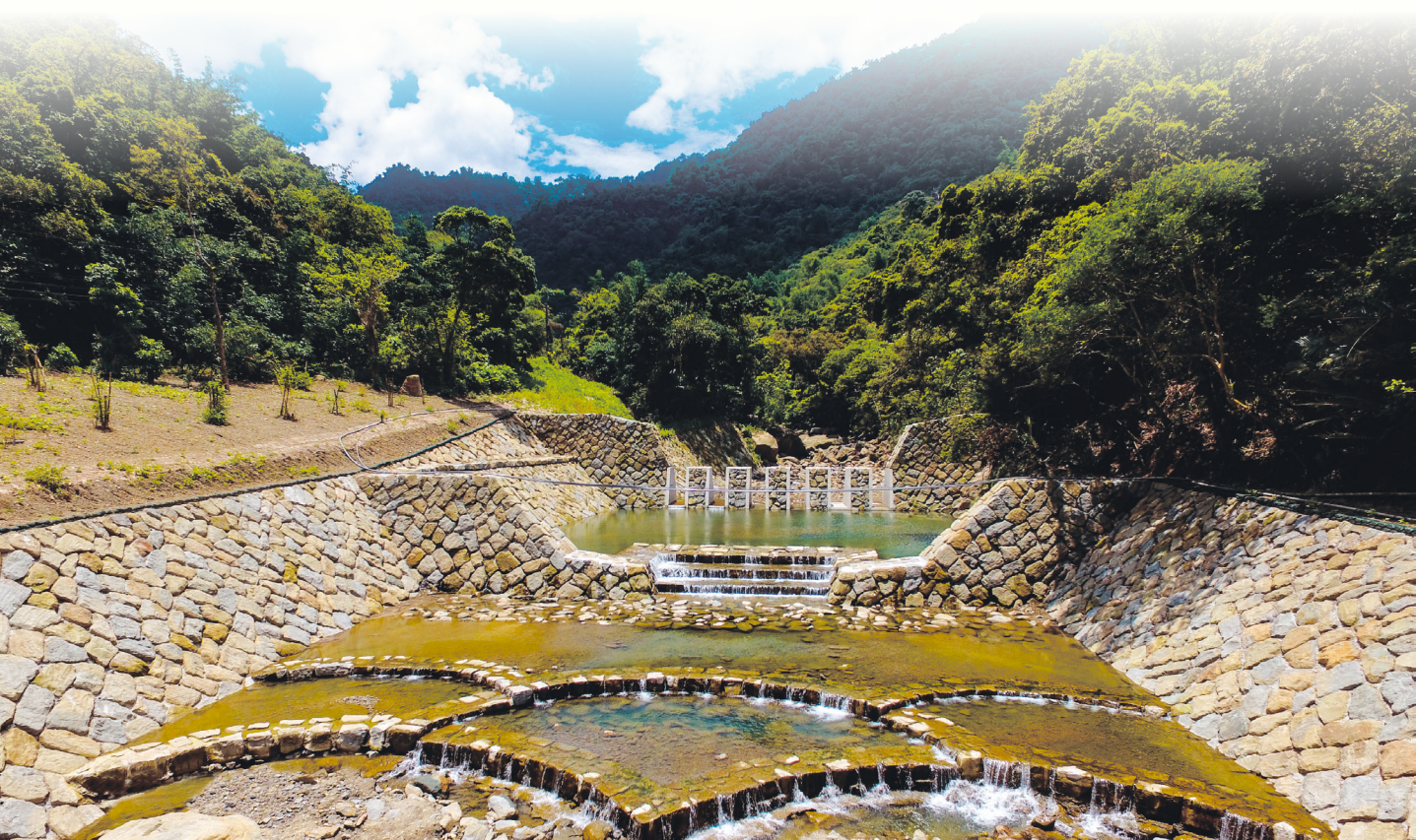
東西坑溪崩塌地及野溪治理七期工程（嘉義縣大埔鄉）。
