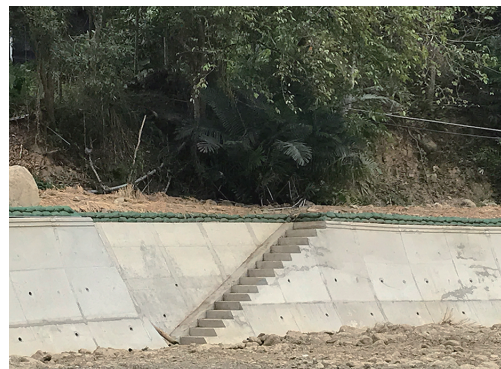
抽藤坑溪治理工程消防及動物坡道，亦提供慢活親溪的民眾安全的通行路徑。
