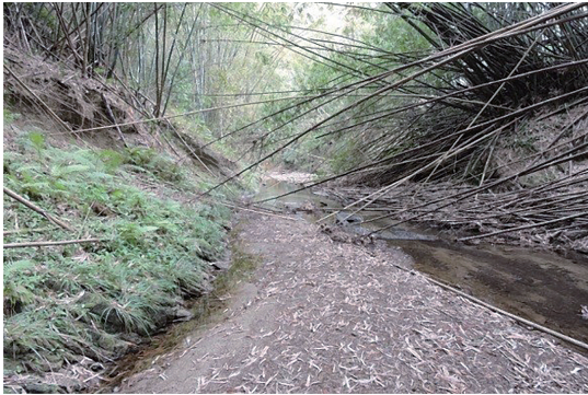
枋寮野溪沖蝕右岸造成竹叢倒塌。
