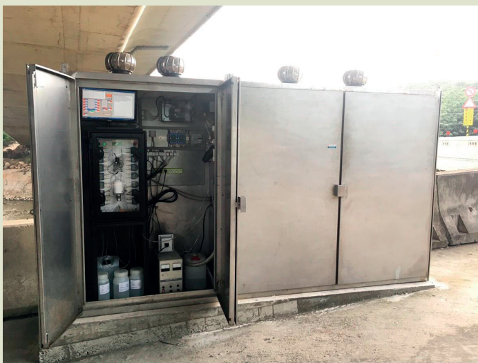
圖 2. 連續水質重金屬自動監測站（桃園水利會新街溪上游測站）。
