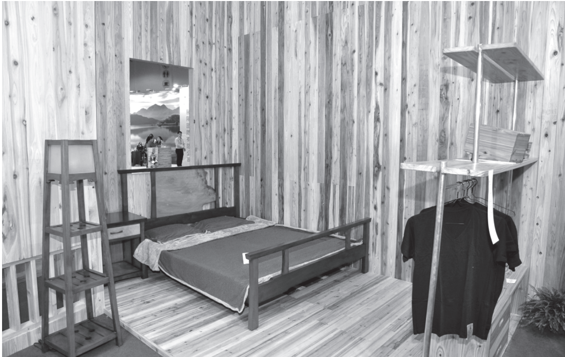
使用國產材柳杉做為臥室裝修。
