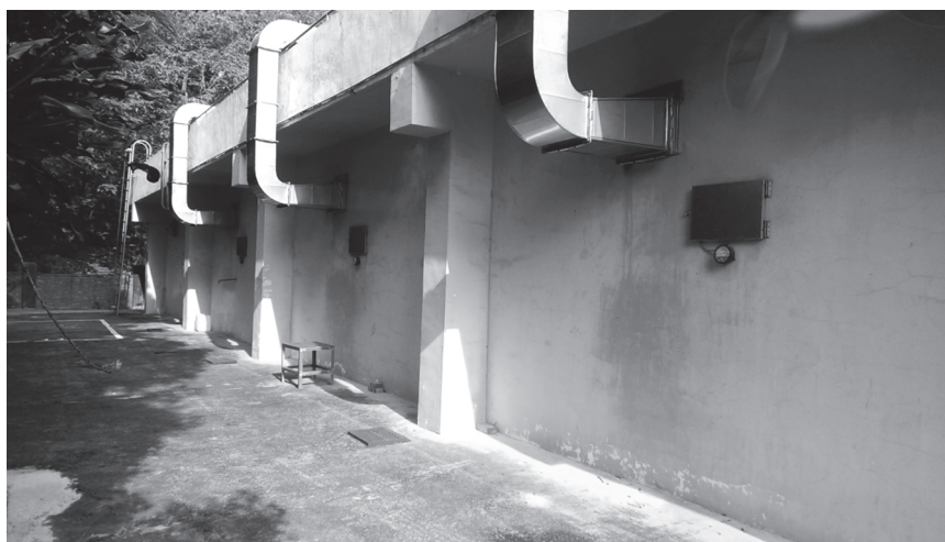
SPF 雞舍為完全屏蔽的磚造建築，內部正壓環境以空調設施進行監控。 圖片提供：檢定分所實驗動物研究系。
