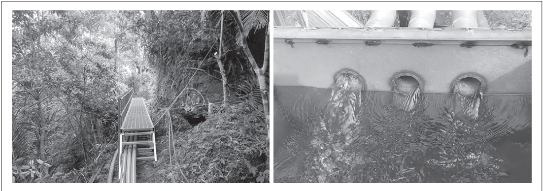
臺東縣成功鎮橘子山取水設施工程成果。
