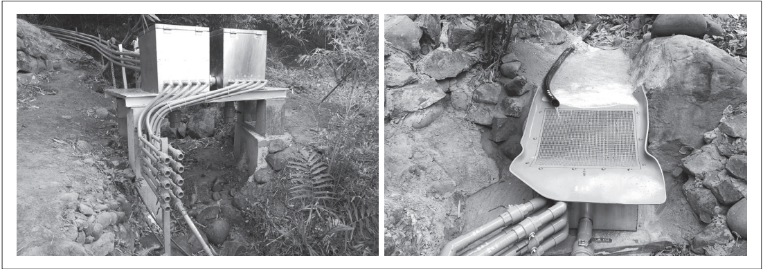
新北市五股區觀音里集水設施完工。
