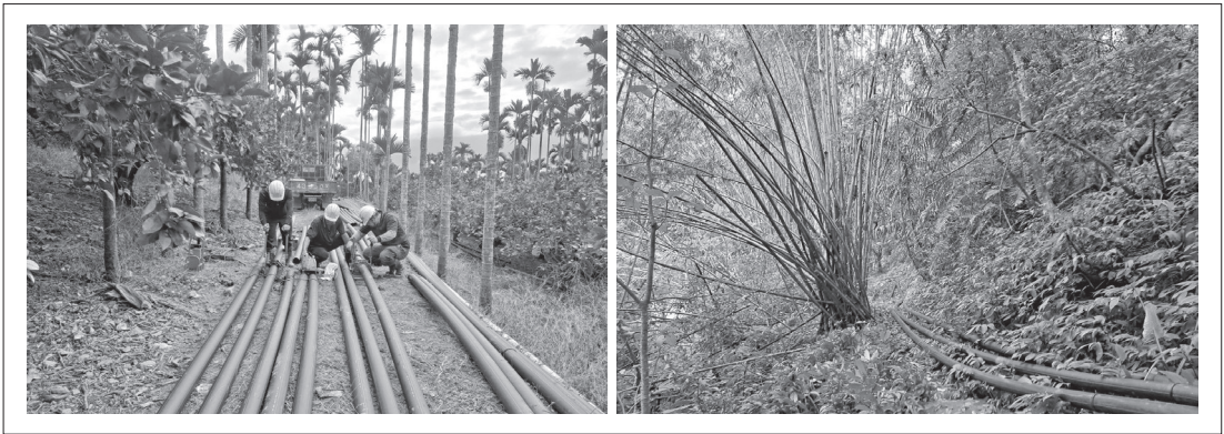
花蓮縣瑞穗鄉舞鶴臺地引水設施第1期工程施工。
