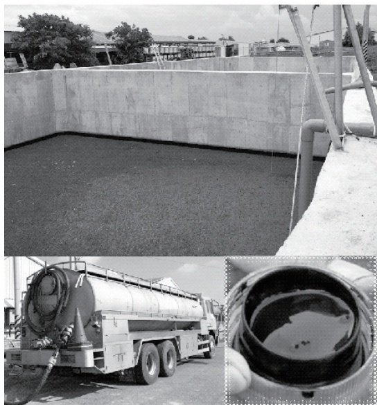
圖 6. 養豬場污泥濃縮設施、載運槽車及植種污泥。 圖片來源：財團法人工業技術研究院。
