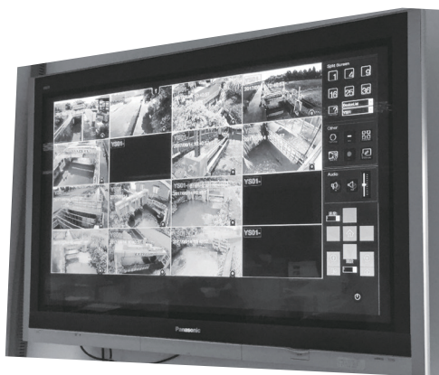
圖 5. 農水署宜蘭管理處灌溉系統監控影像電視牆。
