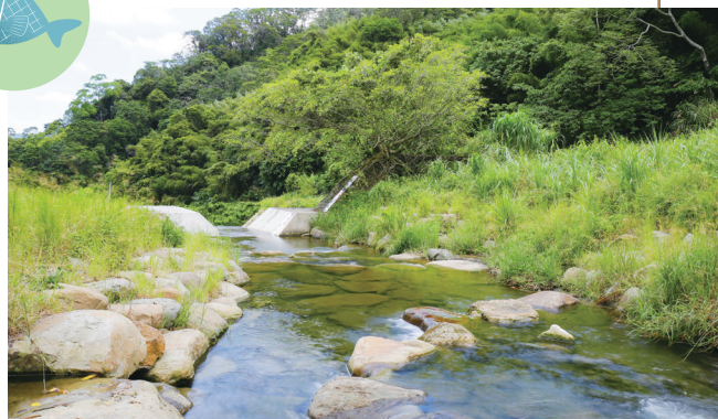
魚道出口一定水量與水深供魚類上溯，深潭蓄積水資源，提供生物生存及農民灌溉需用水，配合植生復育工法改善溪床的微氣候。
