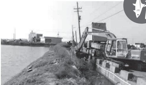
圖1. 彰化縣永興養殖漁業生產區排水路清淤。
