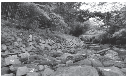
圖1.「大湖鄉富興村芎蕉坑野溪整治工程」砌石固床工。
