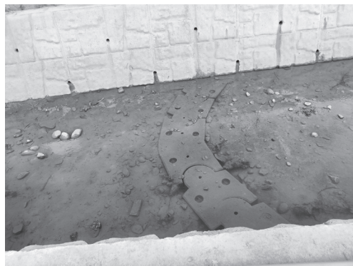
圖8. 南勢溪上南勢坑段野溪整治三期工程預鑄塊石拱型固床工。
