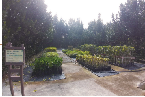
12號苗床硬鋪面採透水性鋪面改善。
