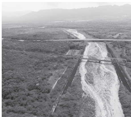
道路與河川構造物瓶頸點改善，為花東縱谷生態廊道串聯的重要策略。
