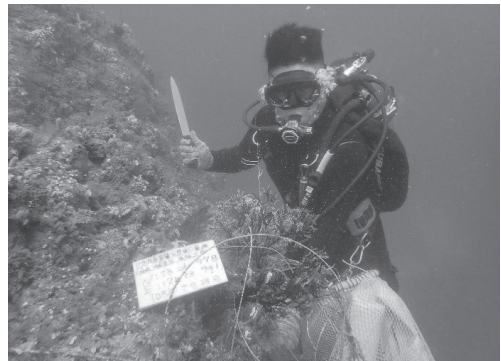
潛水員於水中進行人工魚礁覆網移除作業。
