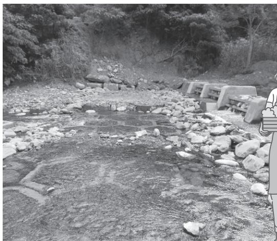
圖10. 蜂巢塊體運用於基礎保護工實景圖。
