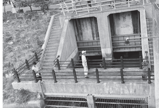
臺東管理處池上圳進水閘門現地抽查。
