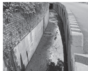
瑠公管理處——社子1區2支線排水。
