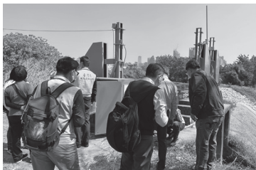
臺中管理處知高本線圳頭排水門現地抽查。
