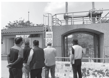
南投管理處溪州埤制水閘門現地抽查。
