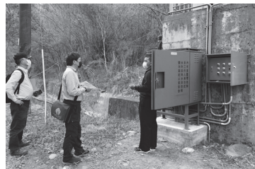
高雄管理處旗山圳一幹線進水口進水現地抽查。
