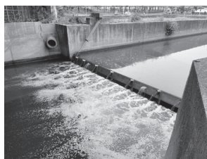
屏東管理處——新園圳制水門。
