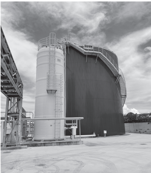
圖1. 全民牧場沼氣發電，建置5,000公噸厭氧消化槽，共處理1萬7,239頭豬隻糞尿水，設置495kW發電機組。
