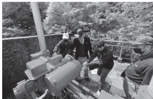
圖 11. 臺中管理處白冷圳取水口制水閘門現地抽檢。
