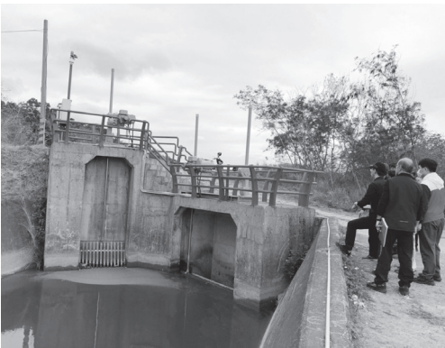
圖 14. 臺東管理處電光圳進水口進水閘門現地抽檢。
