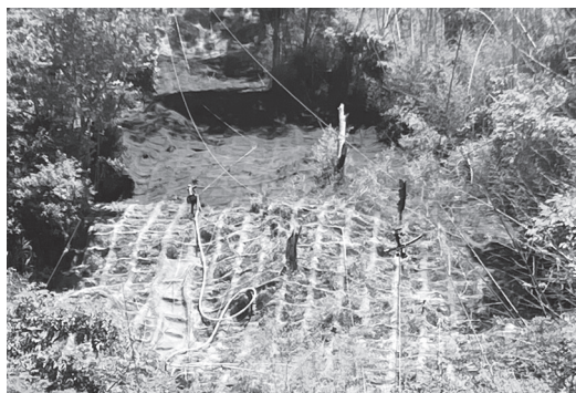
坡面噴植工程（加固抑止）
