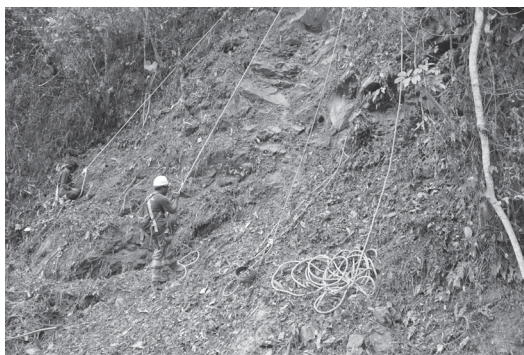
坡面整坡工程（減載抑制）
