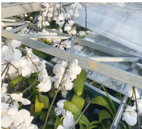
蝴蝶蘭結構型鋼骨溫室受災倒塌。
